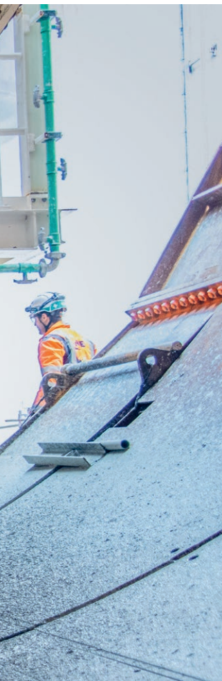
Bild: Arbeiter auf der Grand Paris Express-Baustelle.
