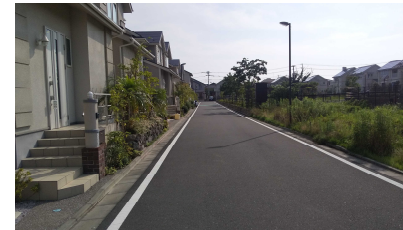
路側帯の設置された道路
