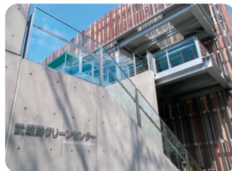
武蔵野市のごみ処理施設「クリーンセンター」
