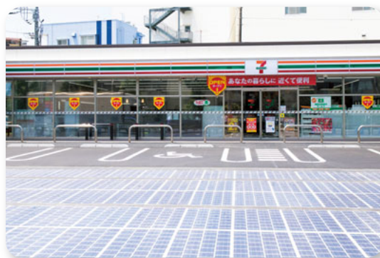
路面型太陽光パネル
