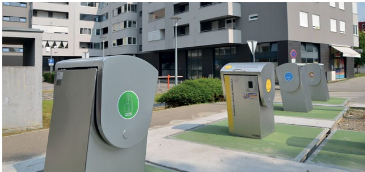
Podzemni spremnici u Zaprešiću
