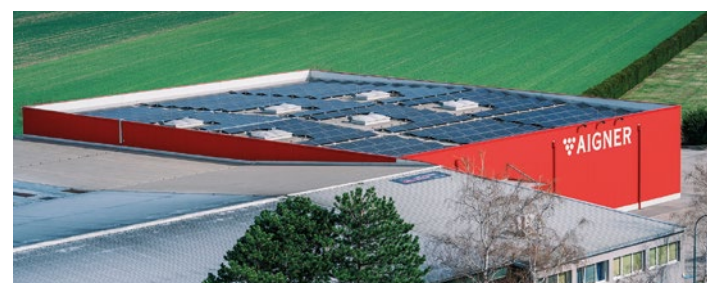
Tony Gligov/Tausendundein Dach
