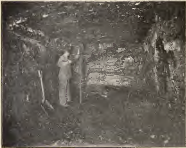
Pari hiilenirroittajaa työssä kaivannossa.
