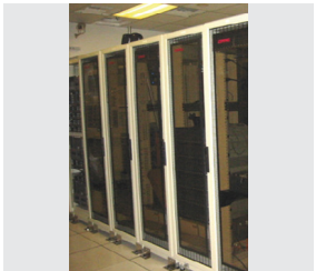
床にアンカー止めがされたコンピュータサーバラック
