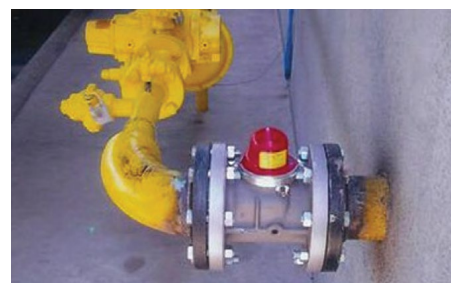
Válvula de cierre sísmico para la tubería de gas natural
