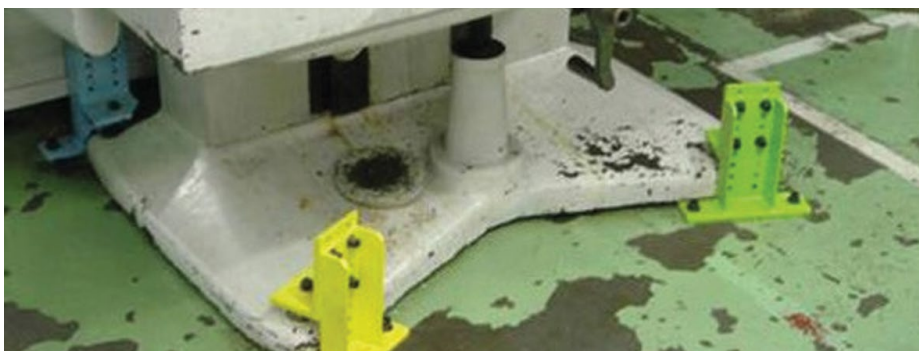
Equipo de producción anclado al suelo
